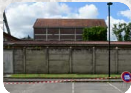
Clôture "1960" actuelle, piliers et plaques de béton préfabriquées
