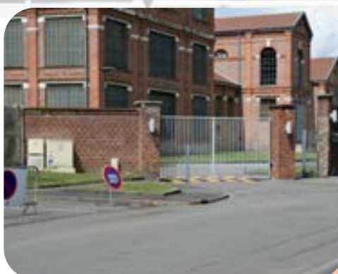
Entrée technique actuelle retouchée en 1960, piliers et murs brique avec portail acier
