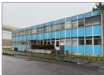
Photo 3 : Vue extérieure: bureaux administratifs
