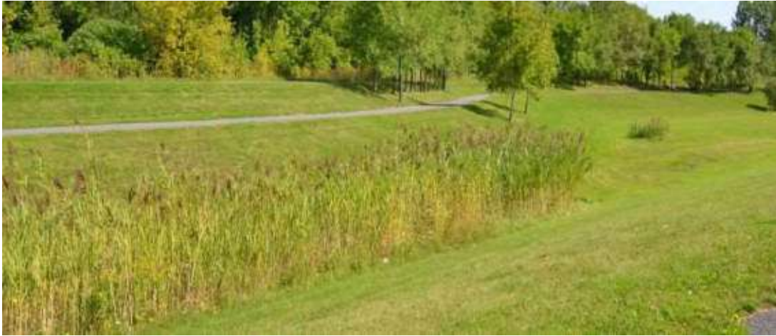
Figure 17 : Image de bassin d'infiltration paysager sur la commune de Saint-Constant. Source : Ville de Saint-Constant
